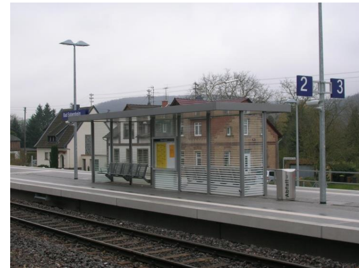
Abb.: Wartehaus auf dem Bahnsteig
